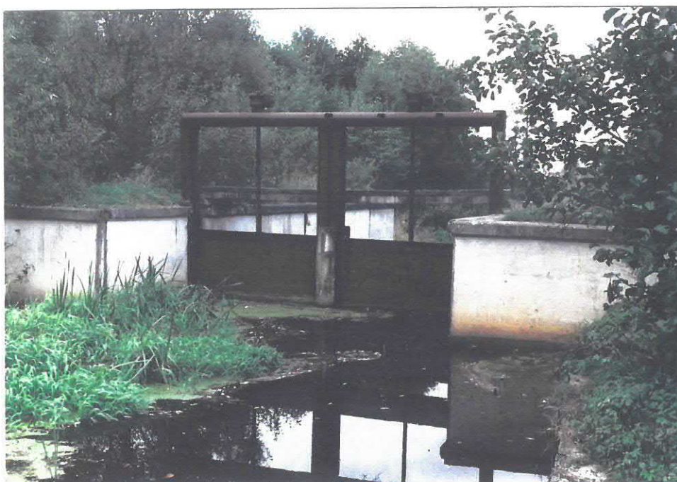
Šliuzas ant Merkio upės ties Merkio-Vokės kanalo ištaka Žagarinės kaime Šalčininkų rajone
