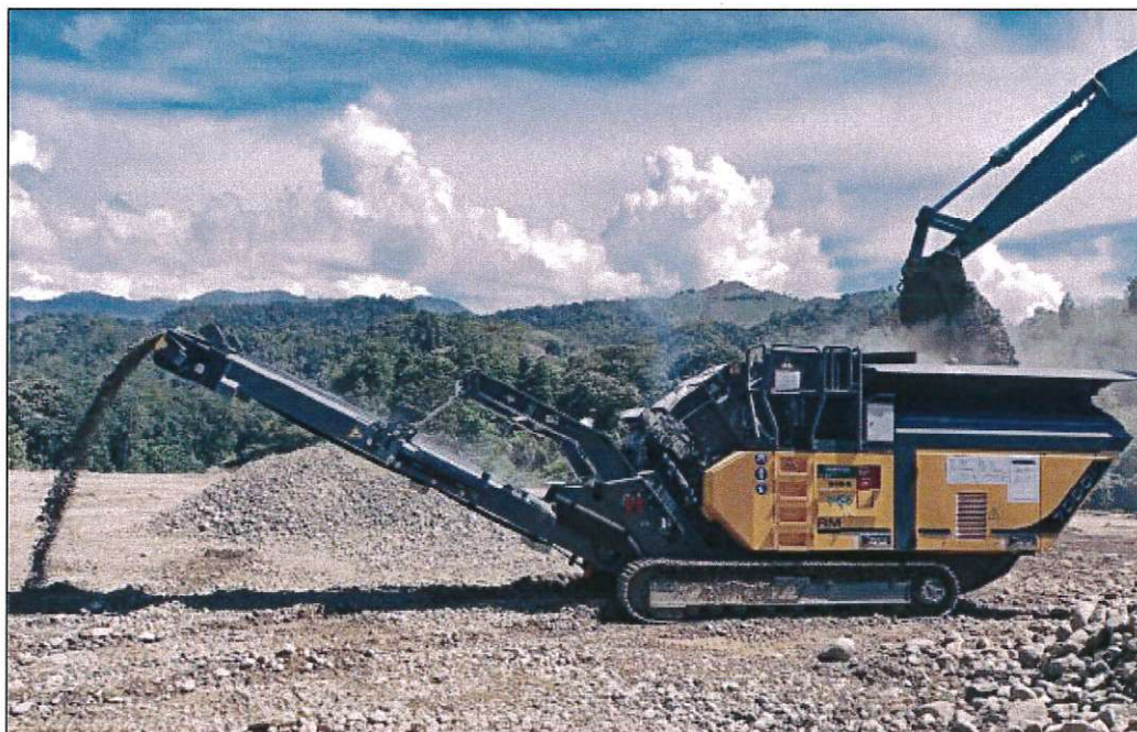
6 pav. Trupintuvas „RUBBLE MASTER RM 70 GO“.
